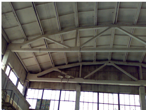
Рисунок 1 – Складчатое покрытие с коррозионными повреждениями после длительной эксплуатации: а – общий вид; б – фрагмент плиты
