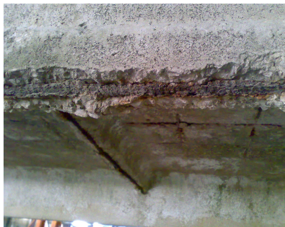
Рисунок 1 – Складчатое покрытие с коррозионными повреждениями после длительной эксплуатации: а – общий вид; б – фрагмент плиты
